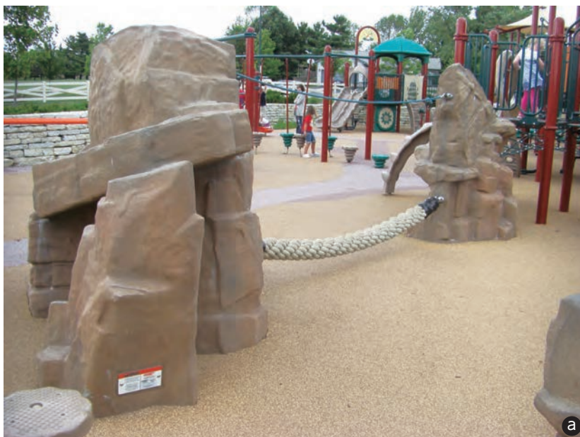
a: 大きな擬岩をつなぎ複合遊具のデッキへと接続するロープ渡りのルート。ロープと地面の色に差があるとなお良い。
